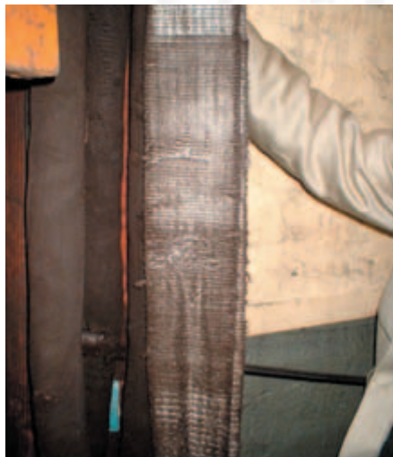
Bild 3-2: Prüfung durch einen Sachkundigen, Beispiel 2
