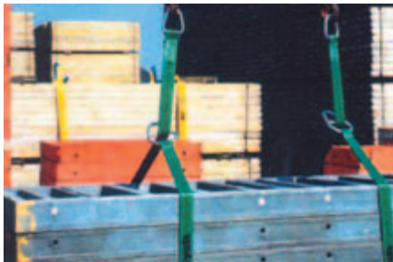
Bild 1-13: Sichere Auflage durch Beschlagteile
